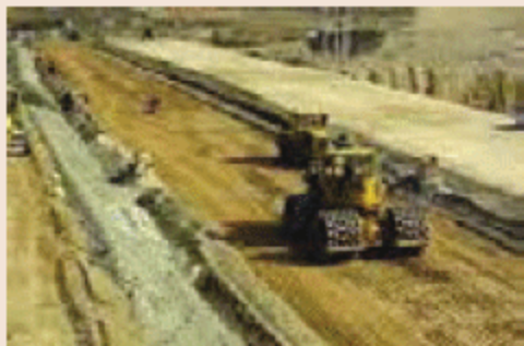
مراحل ساخت سد خاکی
