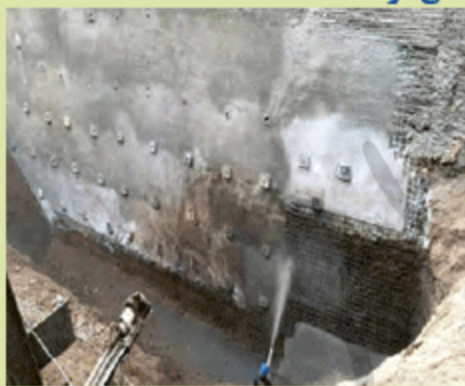
پایدارسازی شیب به روش میخ کوبی
