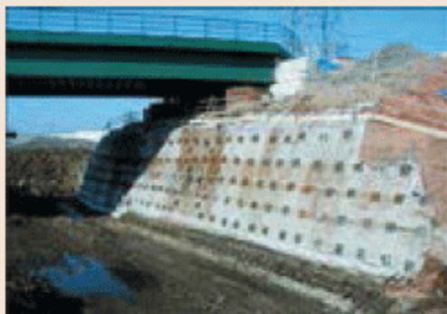
پایدارسازی شیب به روش میخ کوبی
