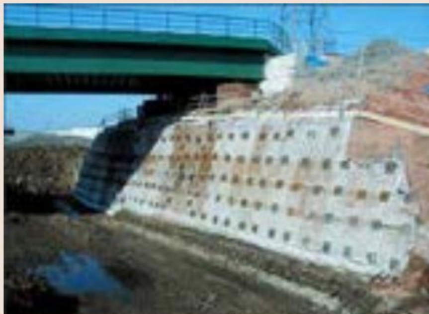
پایدارسازی شیب به روش میخ کوبی
