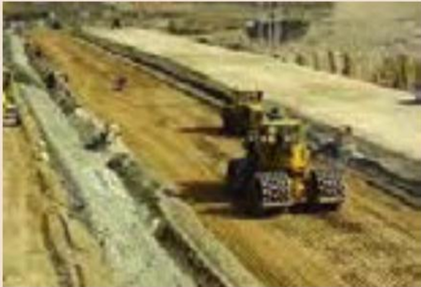
مراحل ساخت سد خاکی
