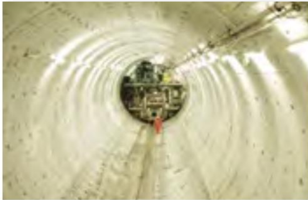
شکل ۴-۶: پوشش داخلی تونل به وسیله قطعات بتن
